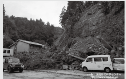
能登半島地震での土砂崩れの被害の様子 出典：一般財団法人消防防災科学センター
