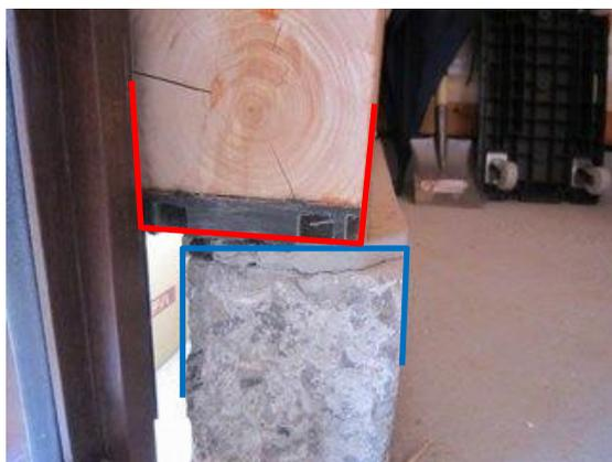
※基礎の幅に余裕が無い場合、土台と基礎のずれが少しでもあれば、土台が基礎からはみ出す状態となるため、このような場合は基礎と土台のずれの大きさにより、要適正管理度の評価を区分するものとする。
