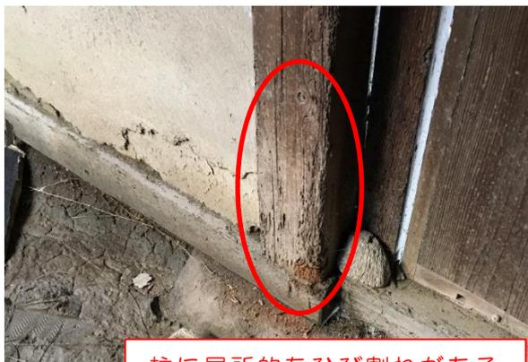
柱に局所的なひび割れがある
