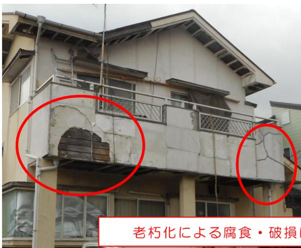
老朽化による腐食・破損により、落下のおそれが高い
