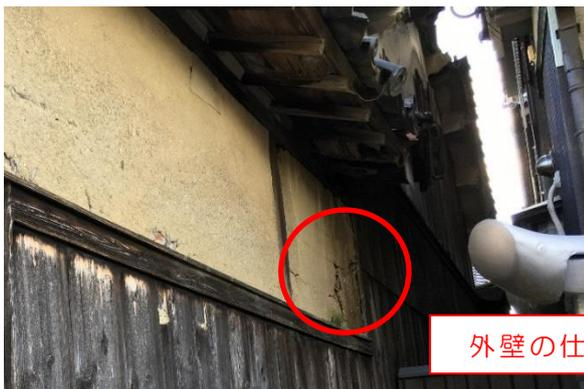
外壁の仕上材料が剥離し、下地が露出している
