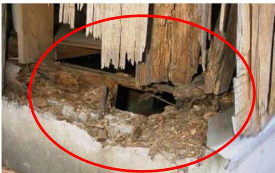
複数の柱、筋かいに大きな亀裂がある
