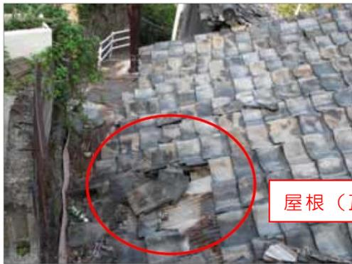
屋根（瓦のみ）が剥落している
