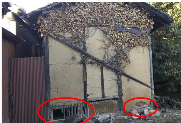
外壁の仕上材料が破損し、壁体を貫通する穴がある
