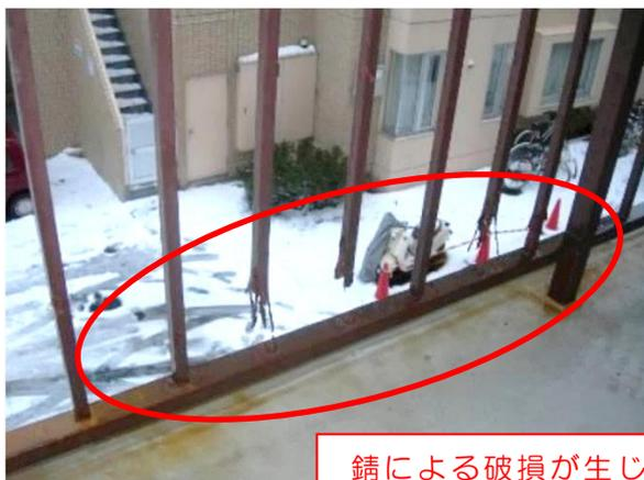
錆による破損が生じている（落下のおそれは低い）
