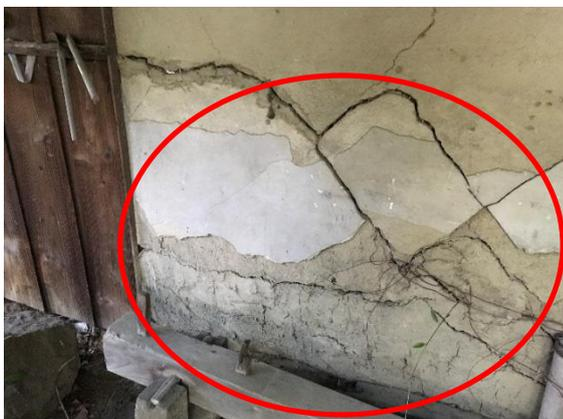
外壁の仕上材料が剥離し、下地が露出して落下のおそれがある
