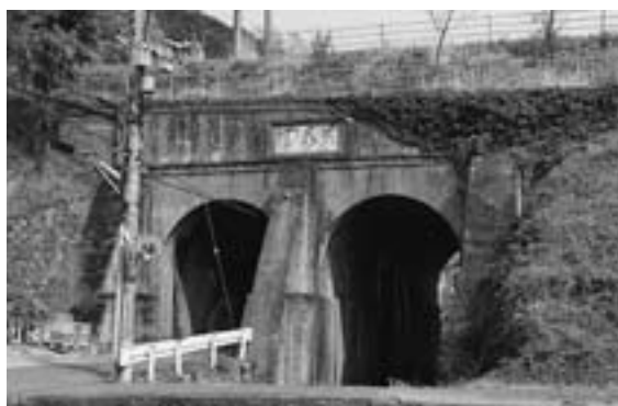
▲レンガ造りのタイムトンネル(薬水門)
