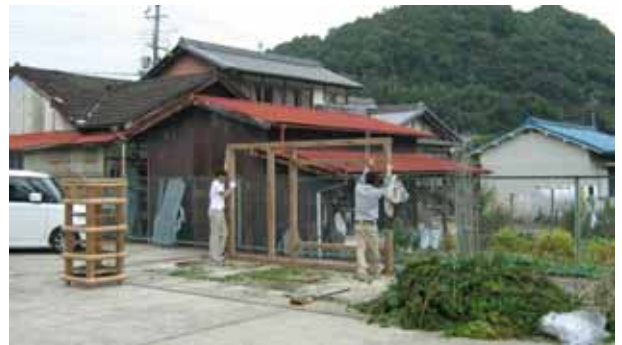
06 オカリヤ解体後
