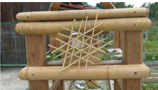
07 解体されたオカリヤと組み物
